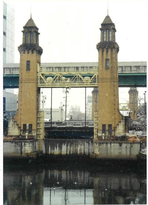
かつて堀川と中川運河は松連閘門を経つたが、ついでに舟運の減少を受けて今は土埋め工の計画
